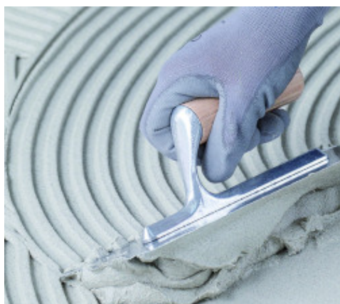
Aanbrengen van Adesilex P9 wit
